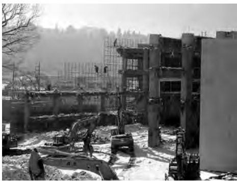
市民会館解体の様子 (2月中旬)
