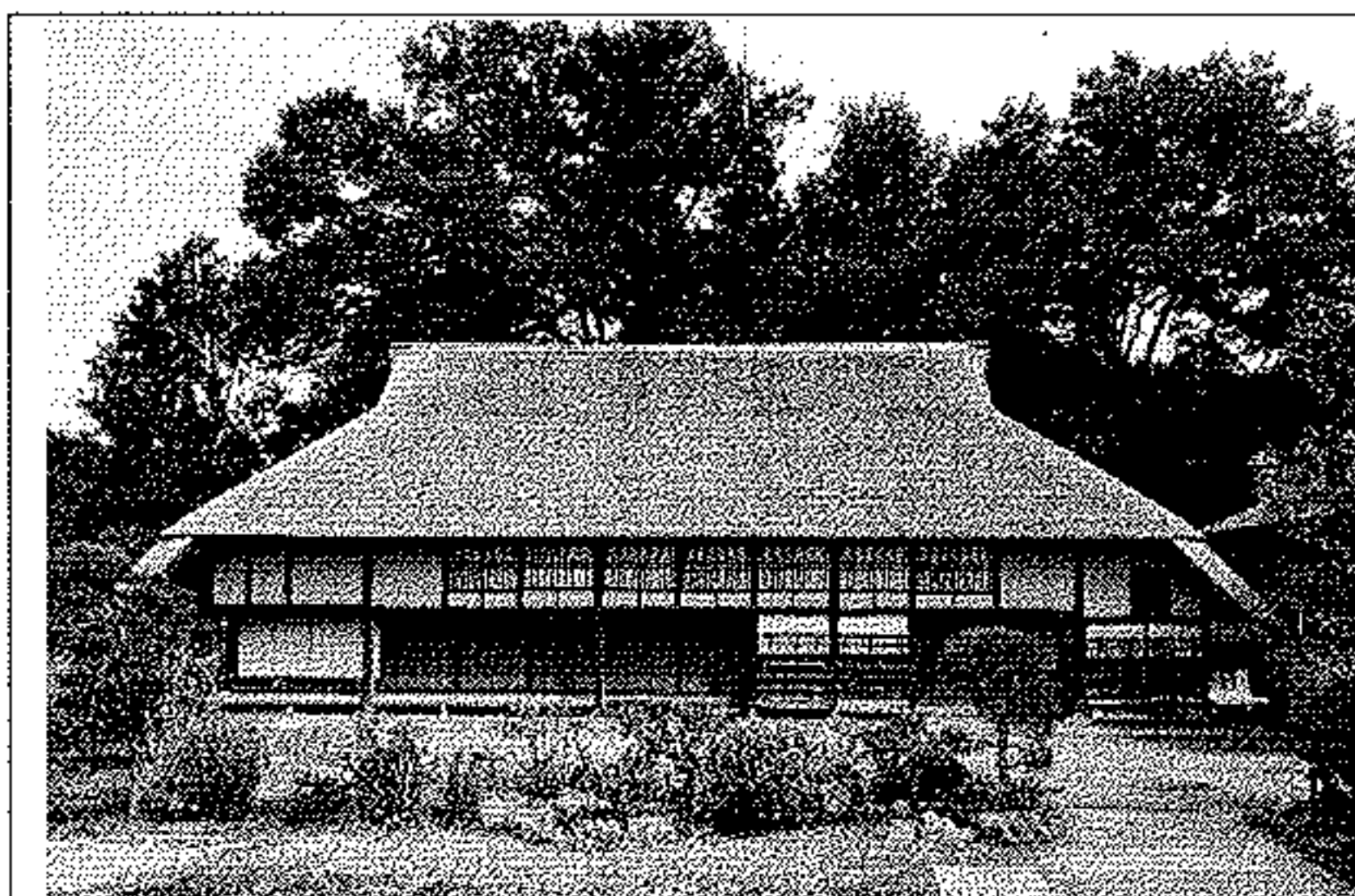
国指定重要文化財(建造物) 内田家住宅
