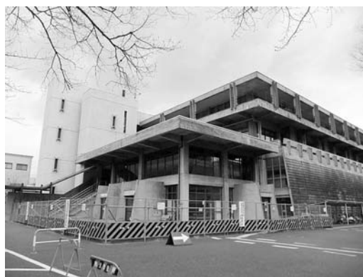
解体費用が予算化された市民会館
