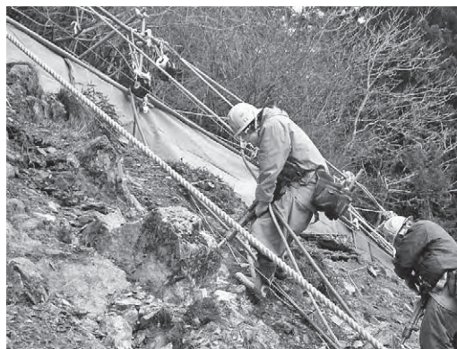
岩掘削作業の様子
