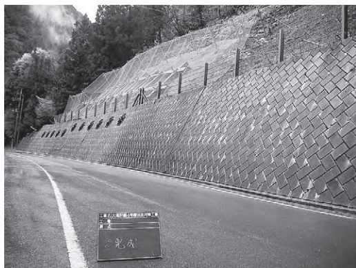
大滝幹線4号線改築事業完成
