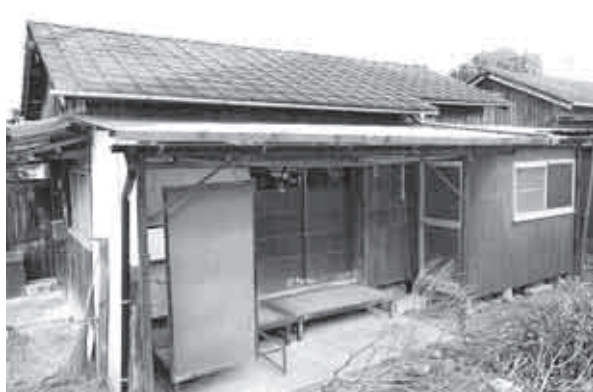
上町にある市営住宅
