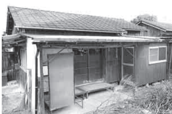
上町にある市営住宅
