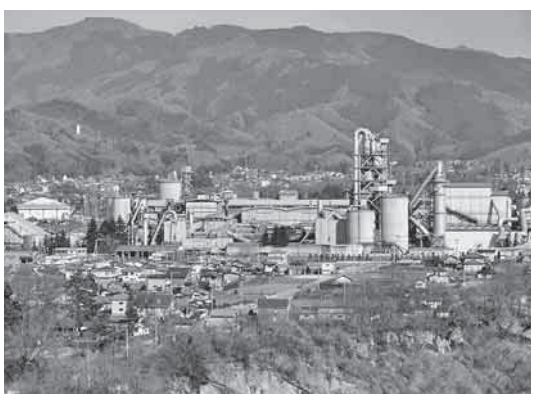
生産中止が発表された秩父太平洋セメント
