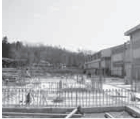
建設が進む高篠小学校の新校舎
