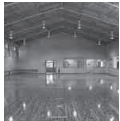
完成した「秩父市あらかわ武道場」
