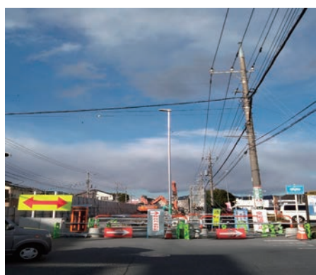
国道140号秩父陸橋の撤去工事
