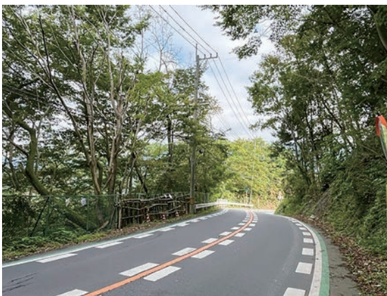
安全対策が望まれる県道72号
