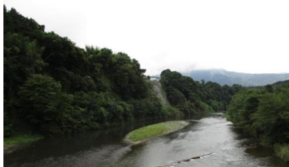
土砂崩落対策工事が施行された荒川の段丘崖 （近戸町）佐久良橋より撮影
