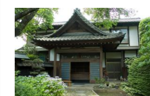
⑭ 藪田家住宅主屋 登録有形文化財 平成16年2月17日登録 秩父市番場町 建築年代：明治末期
