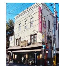
⑤ 安田屋 登録有形文化財 平成16年2月17日登録 秩父市番場町 建築年代：昭和5年頃
