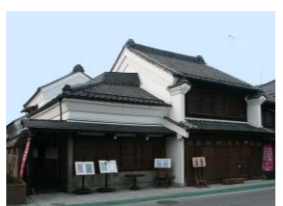
⑰ 旧新井商店居宅兼店舗 登録有形文化財 平成16年2月17日登録 秩父市本町 建築年代：明治初年
