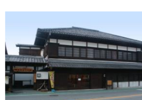
⑱ 旧柿原商店店舗及び主屋 登録有形文化財 平成14年8月21日登録 秩父市本町 建築年代：昭和5年
