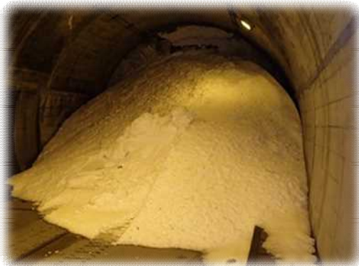
【写真】大滝地区トンネル
