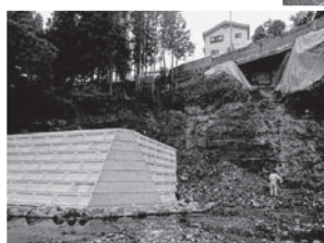
横瀬川護岸工災害復旧後の現況
