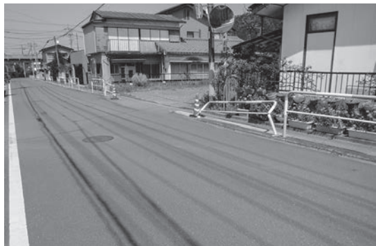
安全対策を講じたい幹線69号線 (札所12番野坂寺西側の市道)
