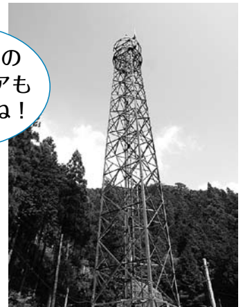
携帯電話基地局 (浦山川俣) ※市で整備
