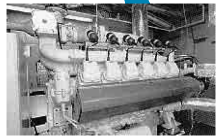
▲発生したガスを燃料にしてガスエンジンを動かし、発電機を回すと電気の供給開始！
