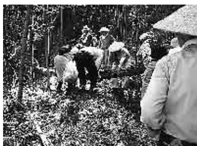
実例：巡礼古道の障害となる倒木の撤去と雑草の除去
