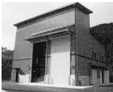
バイオマス発電所
