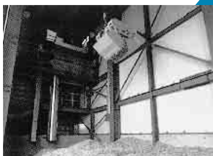
▲ストックヤードからクレーンにより乾燥機に運ばれるチップ。これが、発電の源！
