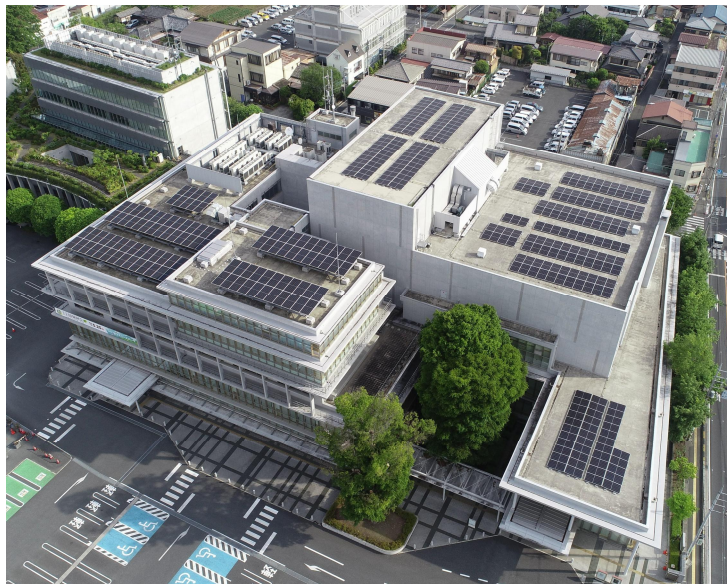
本庁舎及び市民会館屋上の太陽光パネル
