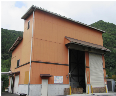
ちちぶバイオマス元気村発電所
