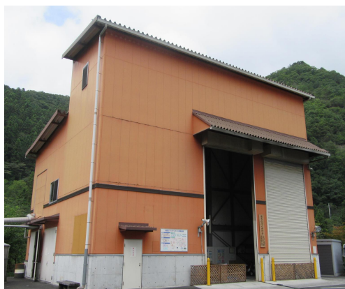
ちちぶバイオマス元気村発電所
