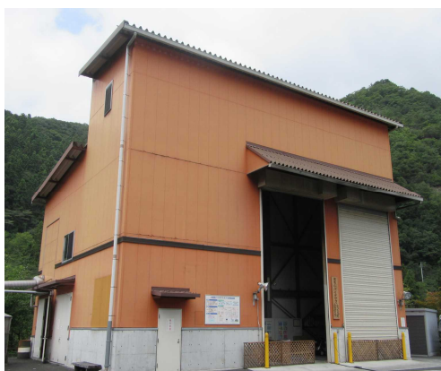
ちちぶバイオマス元気村発電所
