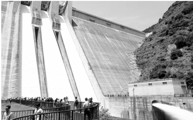
5月27日、滝沢ダムで点検放流が行われました。大雨により流入量が増加した際に下流の被害を軽減するため、ダムから放流量を調整する「洪水吐きゲート」が備えられています。ダム管理開始以降で4年ぶり2度目の点検放流でした。約850人の来場者が訪れ、普段なかなか見ることができないダイナミックな光景を満喫していました。
