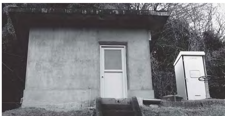
西岸低区送水ポンプ場
