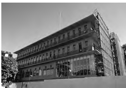
建設中の市役所本庁舎及び市民会館
