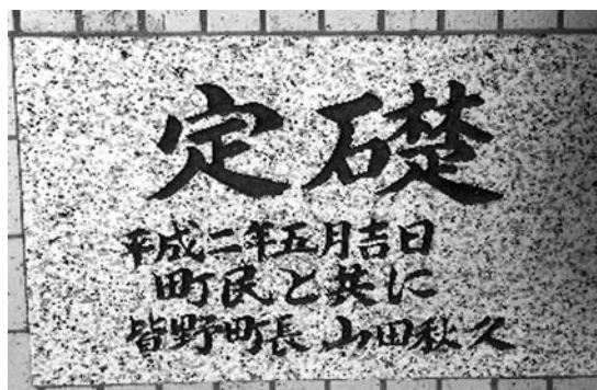
「町民と共に」の文字が刻まれた 皆野町役場の定礎プレート
