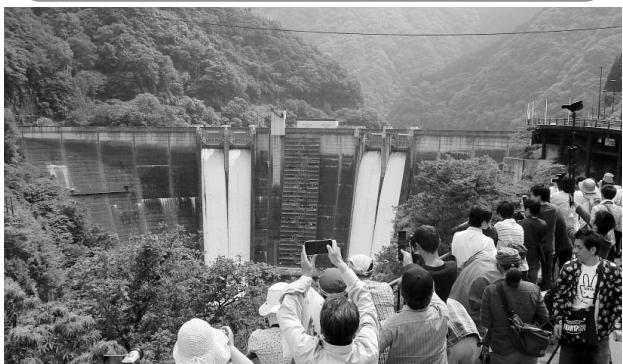
5月29日、二瀬ダムで非常用放流設備（クレストゲート）の点検放流が行われました。7月1日の夏期制限水位に向けて、貯水位を徐々に下げる操作の一環として、点検と洪水対応訓練を兼ねて実施されたものです。4門同時放流は21年ぶりのことから、普段見ることのできない、ダイナミックなダム放流をひとめ見ようと、多くのダムファンや見学者が訪れました。
