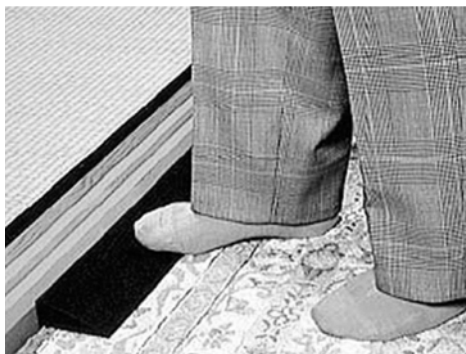
写真 踏みつけ板の設置
