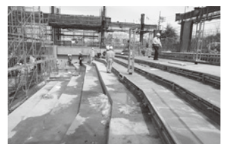
ホール客席部分の工事状況
