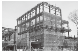
工事現場の様子
