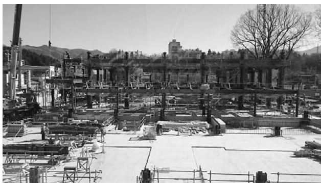
建設中の本庁舎等
