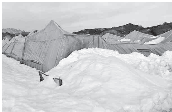
雪の重さで倒壊したビニールハウス
