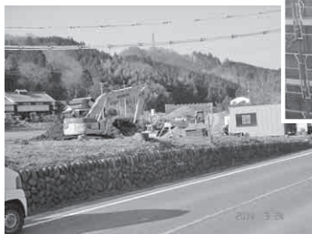
工事が進む連絡道（国道299号線付近）
