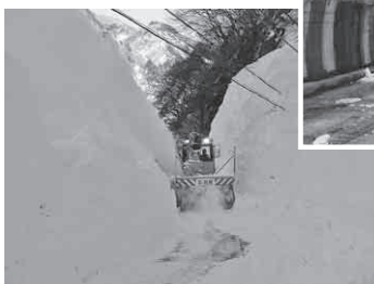
トンネルを塞いでしまった高さ10m 近い雪崩の除雪
