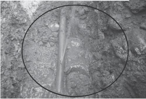
漏水状況(給水管)
