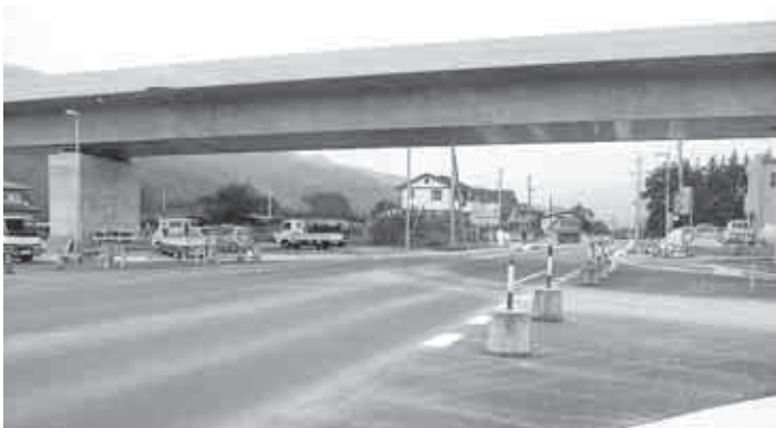
整備が進められている道路 (小柱インターチェンジ付近)
