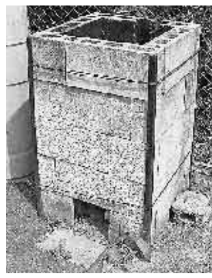
ブロック積簡易焼却炉
