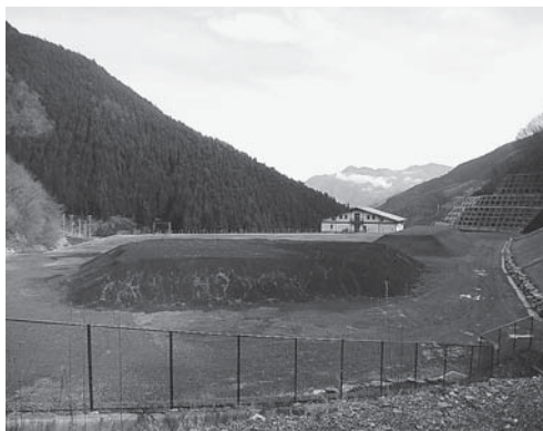
建設中のBMXコース
