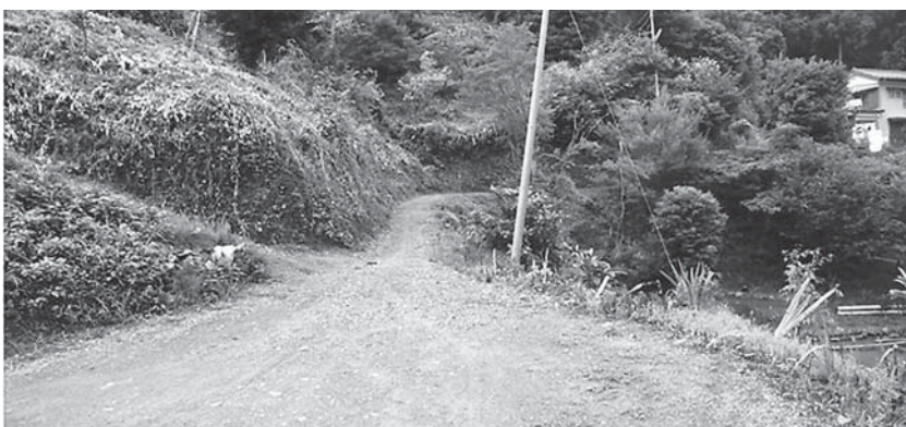
工事予定の石間24号線
