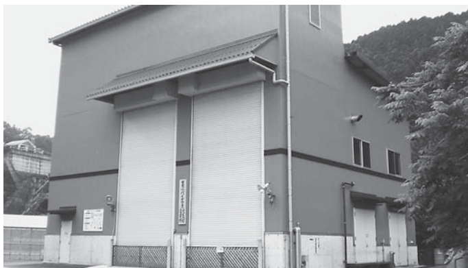
バイオマス発電所
