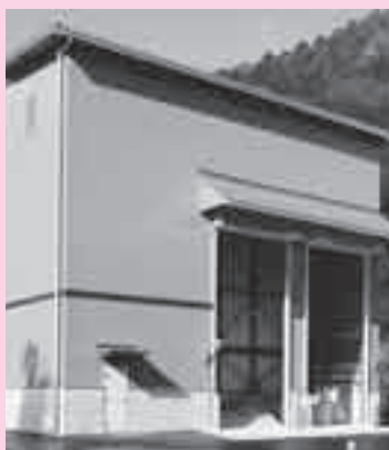
運転を再始動するバイオマス発電所
