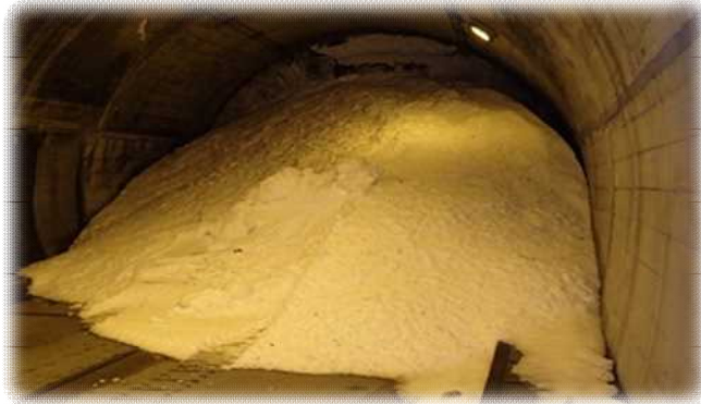
【写真】大滝地区トンネル
