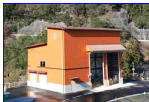
ちちぶバイオマス元気村発電所
