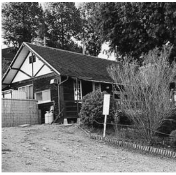
別所グラウンド管理棟
