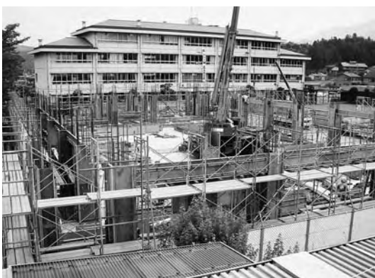
高篠中学校体育館改築工事の現場
