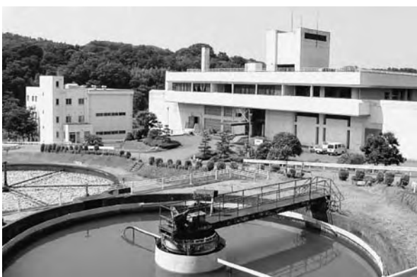
秩父市下水道センター
