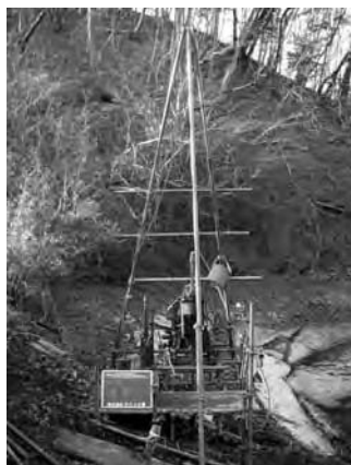
峰沢池のボーリング調査
