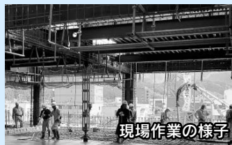
工事現場の様子
