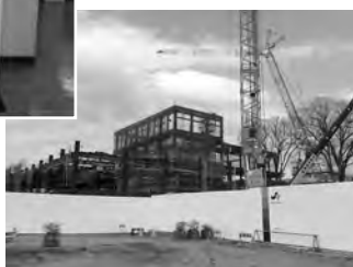
建設中の本庁舎・市民会館
