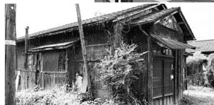
老朽化した野坂二瀬市営住宅
