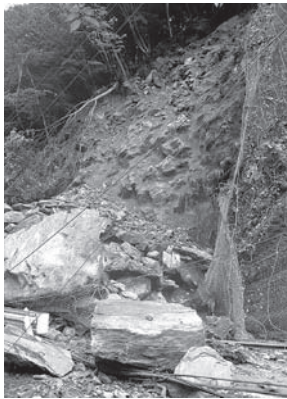
7/20に発生した大滝大久保地内の土砂崩れ
